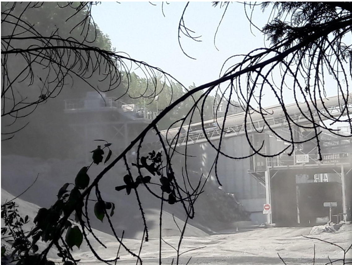
Photo 1 : Nouvelle installation au pied de la rue d'en bas
